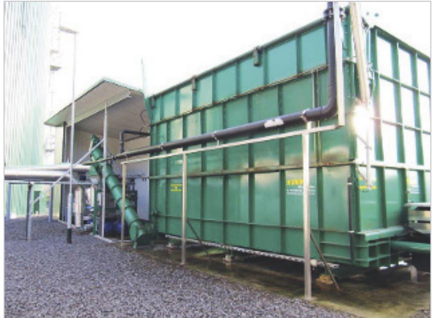
*Rohstoffbeschickung der Biogasanlage*
